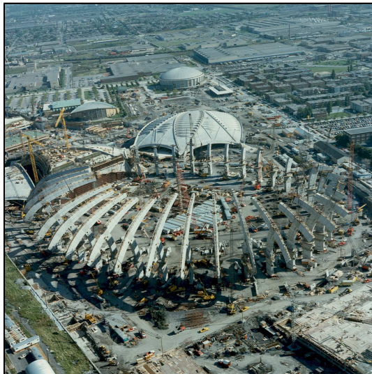
The Olympic Stadium under construction. Source : Ville de Montréal. Gestion de documents et archives.
