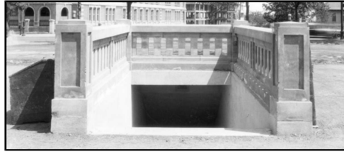
Tunnel piétonnier de la rue Sherbrooke en face de l'hôpital Notre-Dame, [193-]. Source : Ville de Montréal. Gestion de documents et archives.
